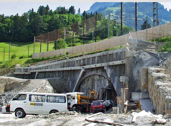
Rohrschirm-Vermessung in Frutigen
