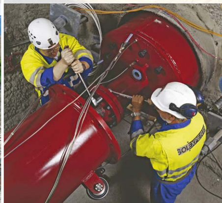
Installation «Mega-Packer» im Felslabor Mont Terri
