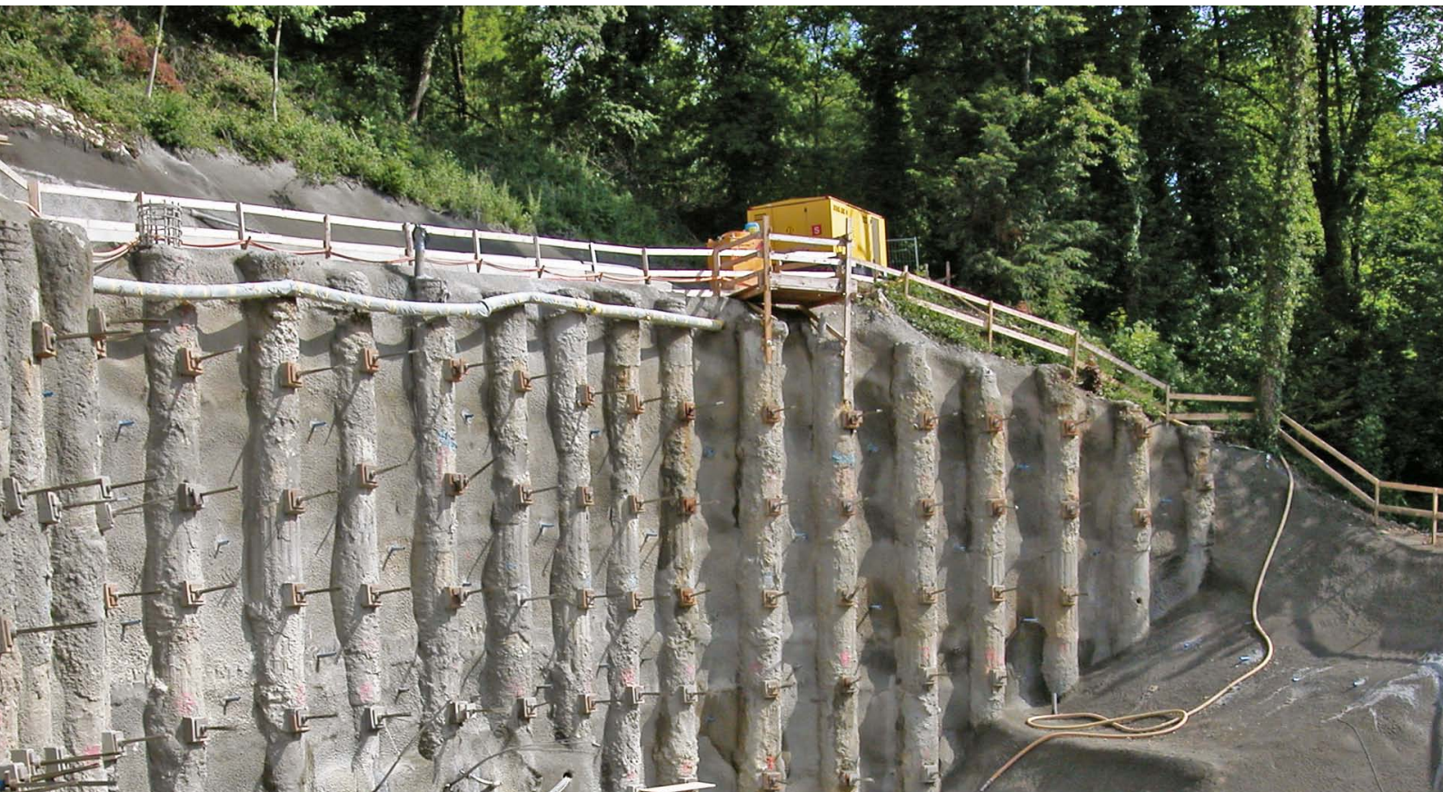
Umfahrung Aarburg, Kanton Aargau: Überwachung Baugruben
