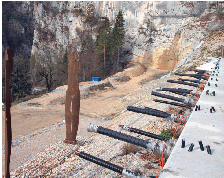
Überwachung Felsmassiv während Sprengvortrieb für den neuen La Roche Tunnel.
