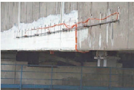
Instrumentierung Brücke mit kettenweise angeordneten Oberflächenextensometern. Infolge schlechtem Zustand der Brücke werden die Verformungen der Brückenträger laufend überwacht und mit den anlässlich einer Probelastung ermittelten Verformungen verglichen.
