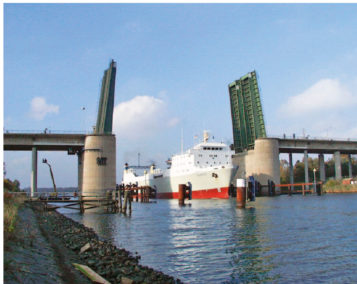
Instrumentierung Brücke mit kettenweise angeordneten Oberflächenextensometern. Infolge schlechtem Zustand der Brücke werden die Verformungen der Brückenträger laufend überwacht und mit den anlässlich einer Probelastung ermittelten Verformungen verglichen.
