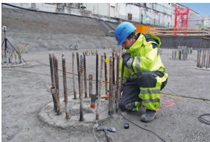
Pfahluntersuchung mit dem Impuls-Echo-Verfahren
