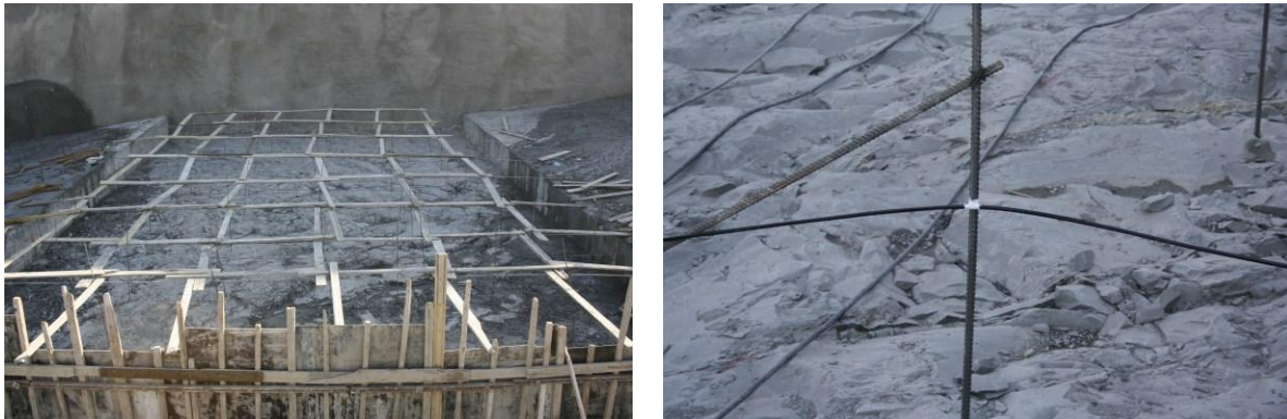
Befestigung des faseroptischen Kabels an Hilfskonstruktionen
