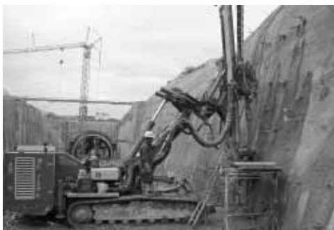
Figure 10. Mise en place d'un micropieu
