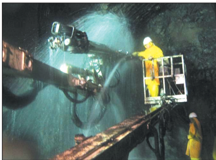
Photo 2 - Utilisation du jumbo pour les sondages d'exploration
