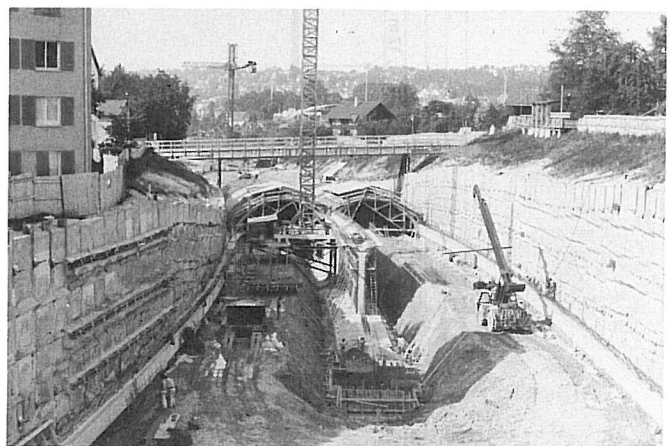
Abb. 10 — Tunnel Stephanshorn, Aushubphase vor dem Betonieren des Mittelfundamentes
