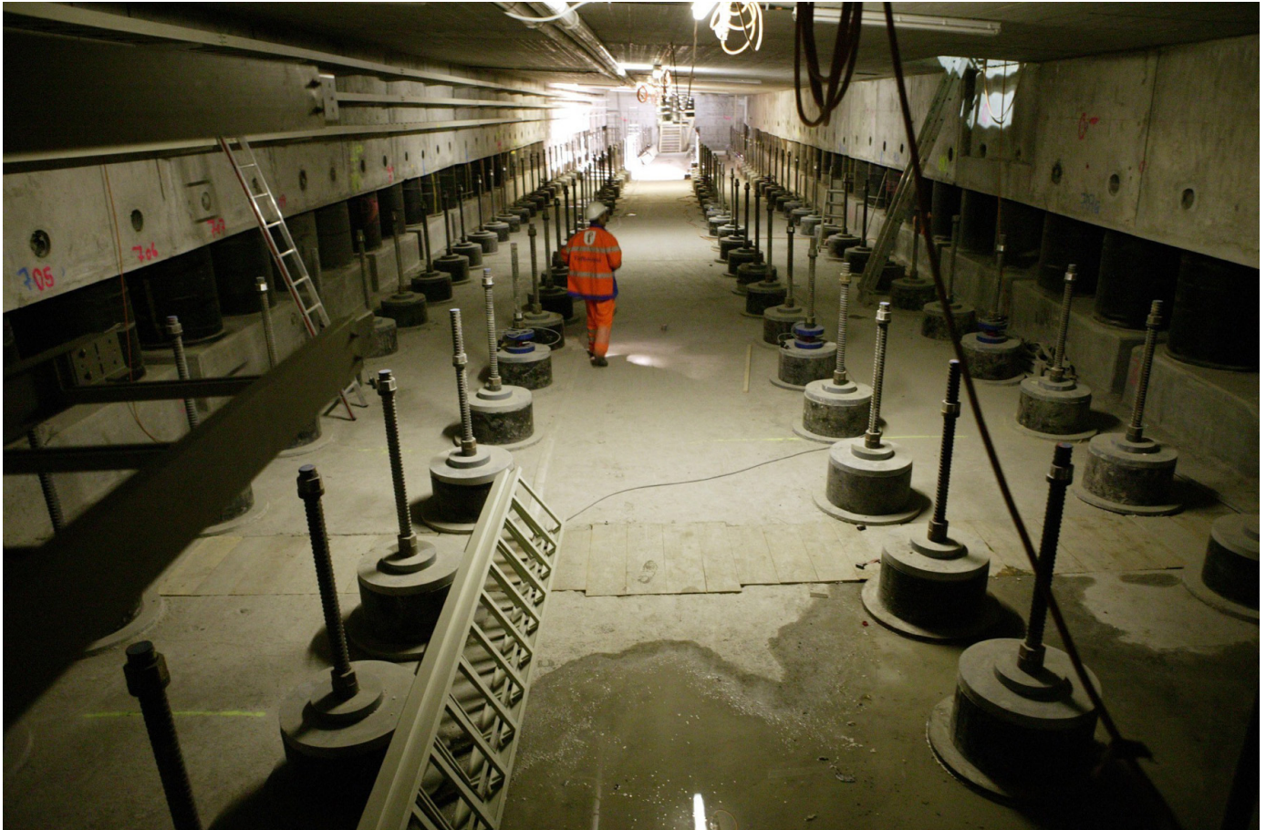
Bild 6: Chienbergtunnel - Sohlbereich unter der Fahrbahnplatte
