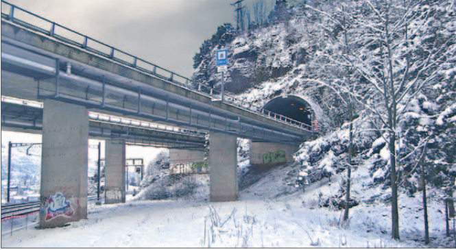
Überwachung und Alarmierung für Felssicherung: Bohrlochextensometer, Ankerkraftgeber
