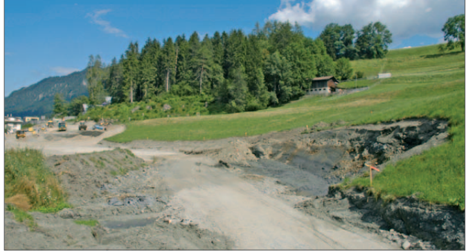
Überwachung eines instabilen Hanges: Inklinometermesskette, Porenwasserdruckgeber
