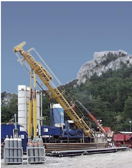
LTF Richtbohrung Avrieux
