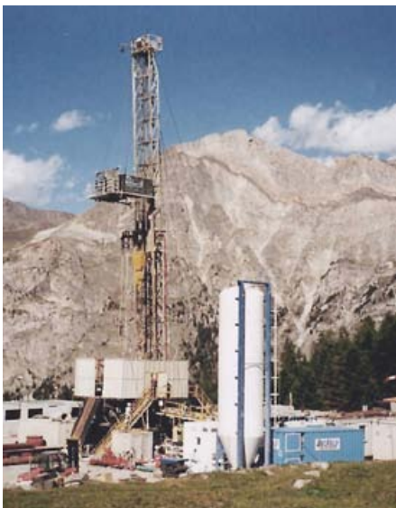
LTF Richtbohrung Etache
