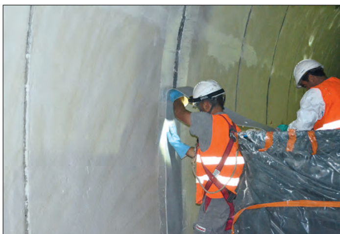
Pose d'une bande élastomère en pontage de joint de plot / Installing an elastomer strip to bridge a segment joint.
