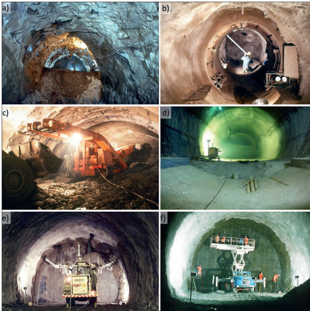
Figure 4 - Photos des travaux. • En haut : galerie de reconnaissance (1979-80) : a) Boulonnage, b) Section d'essai dans les Marnes • Au milieu : Tube Nord (1982-86) : c) excavation de la calotte à la MAP, d) Excavation en 3 parties • En bas : Tube Sud (1992-95) : e) Pleine section excavée à l'explosif, f) Chargement de la volée / Tunnelling works. • Top: reconnaissance gallery, 1979 to 1980 : a) rockbolt installation b) circular test section in marls; • middle: north tube, 1982 to 1986 : c) top-heading excavation with road-header, d) three-staged excavation; • bottom: south tube, 1992 to 1995 : e) full-face drill-and-blast excavation, f) loading of explosives.
