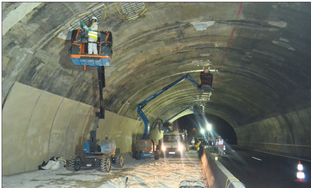
Les zones de béton armé à réparer seront protégées après projection du mortier / Reinforced concrete areas for repair are protected subsequent to mortar spraying.
