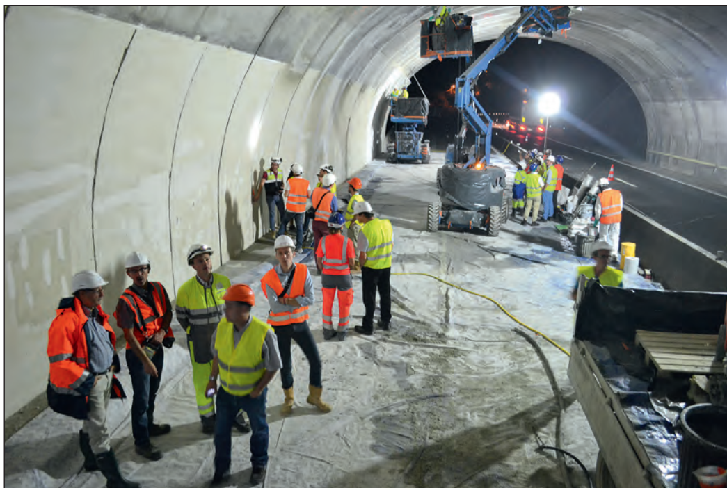
Vue du chantier visité par les membres de l'AFTES / View of the worksite during the AFTES members' visit.
