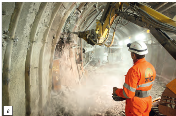
Figure 3 - Photographies de méthodes d'excavation testées dans le Laboratoire souterrain : (a) brise roche hydraulique - (b) Machine à attaque ponctuelle, et (c et d) Tunnelier à attaque ponctuelle en atelier et en opération / Photographs of excavation methods tested in the underground laboratory: (a) hydraulic rock breaker - (b) roadheader, and (c and d) tunnelling roadheader, in the workshop and in operation.
